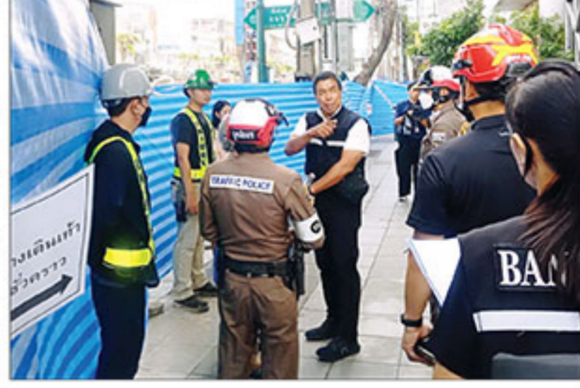
▲ ลงติดตาม : นายชัชชาติ สิทธิพันธุ์ ผู้ว่าราชการกรุงเทพมหานคร ลงพื้นที่ เพื่อติดตามความคืบหน้าการแก้ไขปัญหาเกิดเหตุรั่วไหลภายในอุโมงค์ก่อสร้าง รถไฟฟ้าสายสีม่วงใต้ บริเวณใกล้วงเวียนใหญ่ โดยสั่งมีการตรวจเช็คขนาดถนน ประชิดปิด เพื่อลดแรงดันสะสม ป้องกันไม่ให้อาคารข้างเคียงเกิดการทรุดตัว
