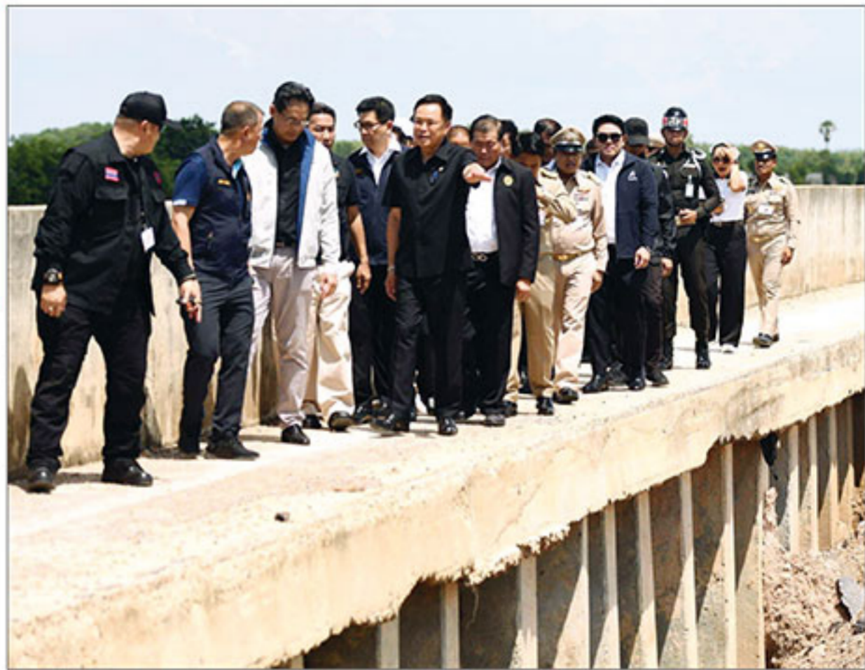
▲ ตรวจค้นคลอง : นายอนุทิน ชาญวีรกูล นายกรัฐมนตรี และรวมมหาฉลามไทย พร้อมด้วยคณะลงพื้นที่ ตรวจสภาพทัศนคลองระบายน้ำ ร.1 (คลอง ร.1) อำเภอหาดใหญ่ จังหวัดสงขลา ที่ถูกกระแสน้ำกัดเซาะ ได้รับความเสียหายเมื่อปี 2568 โดยนายกฯมั่นใจว่าจะสามารถซ่อมทัศนคลองระบายน้ำ ร.1 ได้ทันก่อนฤดูน้ำมา
