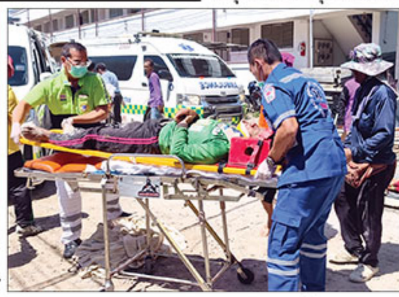
▲ คานด้อม : เกิดเหตุคานด้อมภายในอาคารพลัดตัววางที่อู่ระหว่างก่อสร้าง ด้านหลังสถานีตำรวจภูธรเมืองสระเกษ สูง 5 ชั้น พังถล่มลงมาเสียชีวิต 2 คน และได้รับบาดเจ็บสาหัสอีก 1 ราย ซึ่งทางตำรวจสั่งเร่งดำเนินการตรวจสอบโครงสร้าง ทั้งหมด
