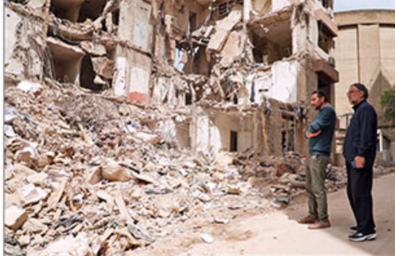
▲ จากสงคราม : สภาพความเสียหายของอาคารอพาร์ตเมนต์ในย่านก๊อเก็งเซด คาซัค กรุงมอสโก ประเทศคาซัคสถาน หลังถูกโจมตีทางอากาศ ทำให้ประชาชนเสียชีวิตหลายราย ท่ามกลางสถานการณ์ความขัดแย้งที่อื้อยิบยิบ
