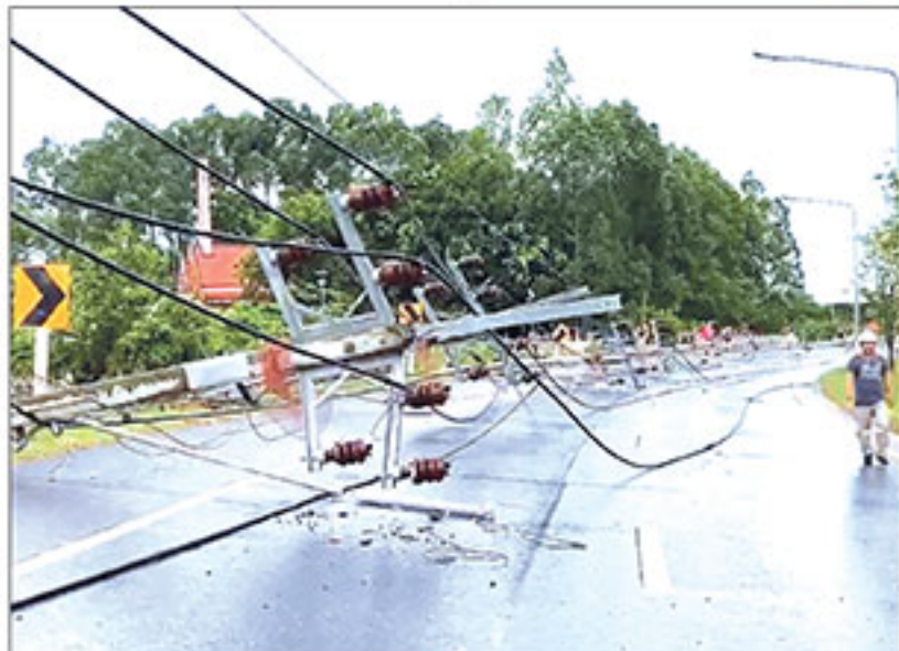
▲ พายุพัด : เกิดเหตุพายุพัดพัดถล่มเขตพื้นที่เทศบาลเมืองนคร บริเวณ ถนน 408 ป้อมเกล้า อ.สิงหนคร จ.สงขลา แรงลมทำให้เสาไฟฟ้าแรงสูงโค่นล้มจำนวน 18 ต้น อีกทั้งยังทำให้สายไฟฟ้าขาดจนต้องปิดการจราจรหนึ่งเส้นทาง ตรวจสอบเบื้องต้นพบ รถยนต์ 1 คัน และรถกระบะ 1 คัน ได้รับความเสียหายคิดอยู่ระหว่างสายไฟฟ้า
