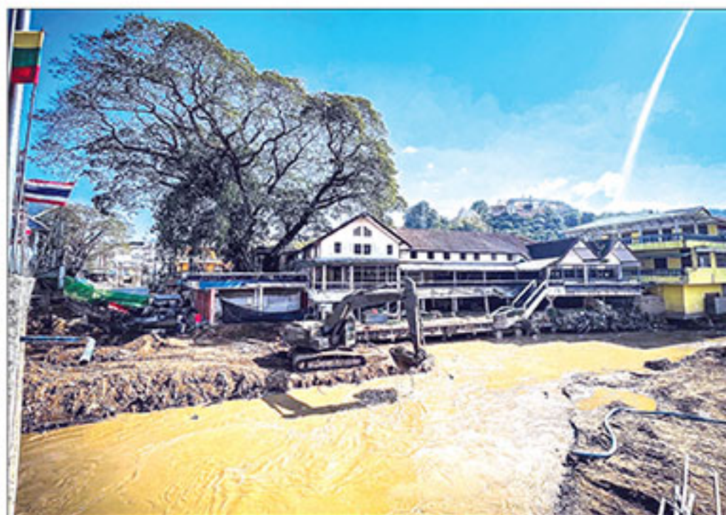
▲ จุดรับผู้ประสบภัย : เจ้าหน้าที่หน่วยทหารช่าง กองทัพบก กองทัพอากาศที่ 3 และทางกรมโยธาธิการ ทำการ ขุดลอกแม่น้ำรวกและแม่น้ำสาย อำเภอแม่สาย จังหวัดเชียงราย เพื่อเพิ่มประสิทธิภาพการระบายน้ำ ตลอดแนวแม่น้ำ เพื่อให้สามารถรับมือกับสถานการณ์น้ำหลากได้อย่างมีประสิทธิภาพในช่วงใกล้ถึงฤดูฝน
