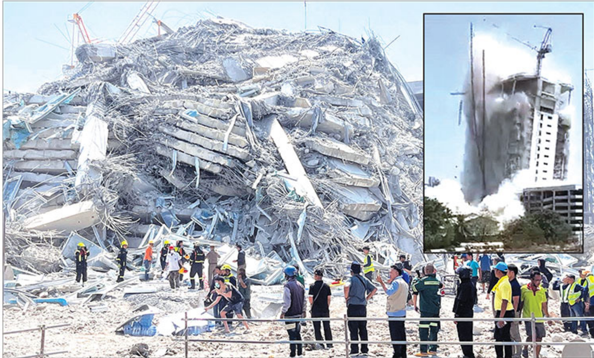
▲ ตึกถล่ม : สภาพหลังเกิดเหตุการณ์แผ่นดินไหวรุนแรง ศูนย์กลางอยู่ในประเทศเมียนมา ขนาด 7.4 ซึ่งส่งผลให้อาคารสำนักงานการตรวจเงินแผ่นดินแห่งใหม่ (สดง.) สูง 30 ชั้น ที่อยู่ระหว่างการก่อสร้าง แถวตึกแดง เขตจตุจักร กทม. ได้ถล่มทรุดลงมาซึ่งมีผู้ได้รับบาดเจ็บติดภายในซากอาคารโดยทางเจ้าหน้าที่นำกำลังพร้อมอุปกรณ์เตรียมเข้าช่วยเหลือ เบื้องต้นพบผู้เสียชีวิตแล้ว 3 ศพ และยังมีผู้สูญหายและติดซากนับร้อยคน
