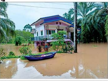
▲ ท่วมสูง : สภาพน้ำท่วมถนนประชาชนภายในบริเวณ หมู่ 3 บ้านห้วยเหือง ต.นาโหนด อ.เมือง จ.ฉะ.ช.ร. เกิดน้ำท่วมสูงกว่า 1 เมตร ทำให้อิได้รับผลกระทบจากการไหลชะของน้ำ ทำให้อิห้วยเหือง และรอบเขตของบึง โดยน้ำสูงระดับน้ำลดลงแล้ว แต่ประชาชนยังคงได้รับผลกระทบ
